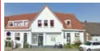
Palet is al enkele jaren onderdeel van Impuls. Maar we vinden het heel mooi om te zien dat het oude pand in Oldenzaal inmiddels weer een fraai woonhuis is geworden!
